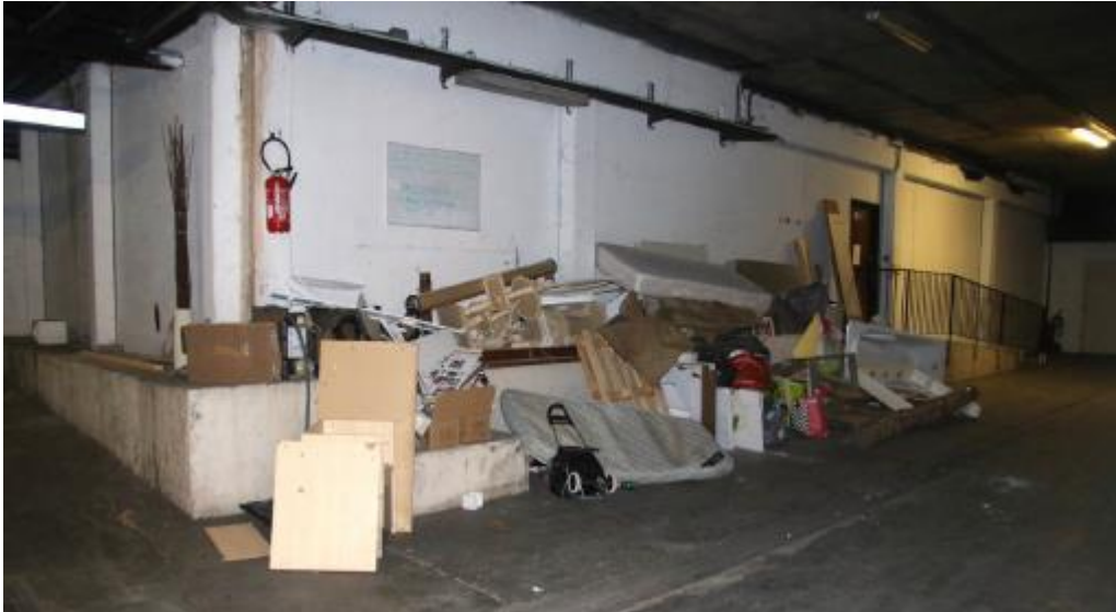
Stockage de produits inflammables dans un espace de circulation.
